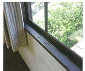
「ちくしのリマド」の施工前と施工後 Before
